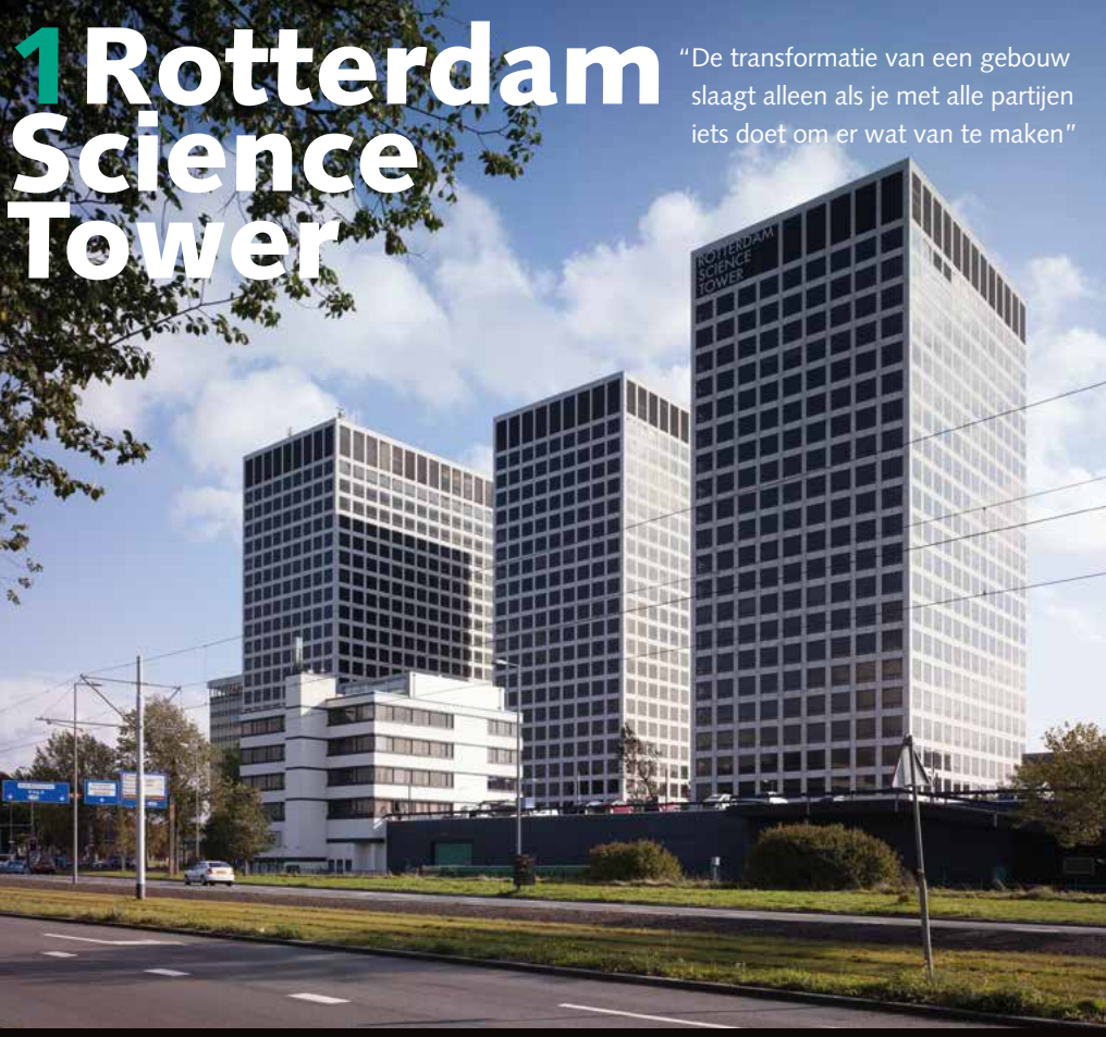
Bouw jaren '60 > Huidige functie Onderzoekslaboratoria en Hogeschool Rotterdam > Transformatie vestiging innovatieve bedrijven > Herontwikkeling door Fortress
